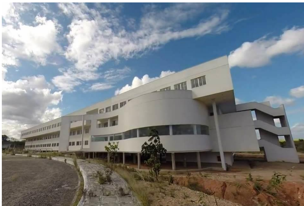
Figura 21: Obras do IIN-ELS
