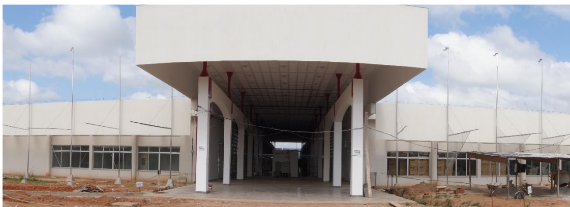
Figura 6: Obras da Escola Lygia Maria Rocha Leão Laporta
