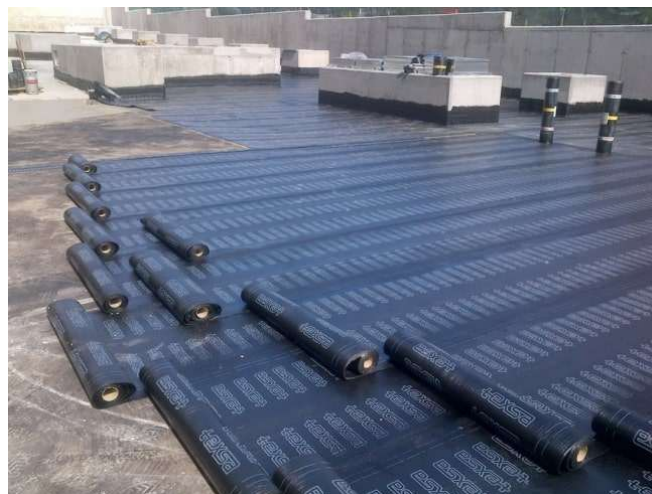
Posicionamento de dupla camada de manta
