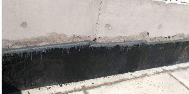
Adesivo epóxi aplicado no arremate da manta
