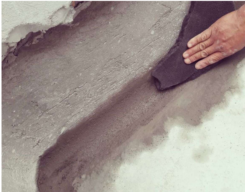
Execução de meia cana no encontro piso x parede
