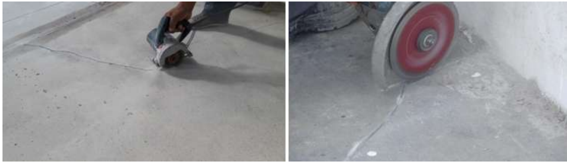
Abertura das fissuras passivas com disco de corte diamantado
