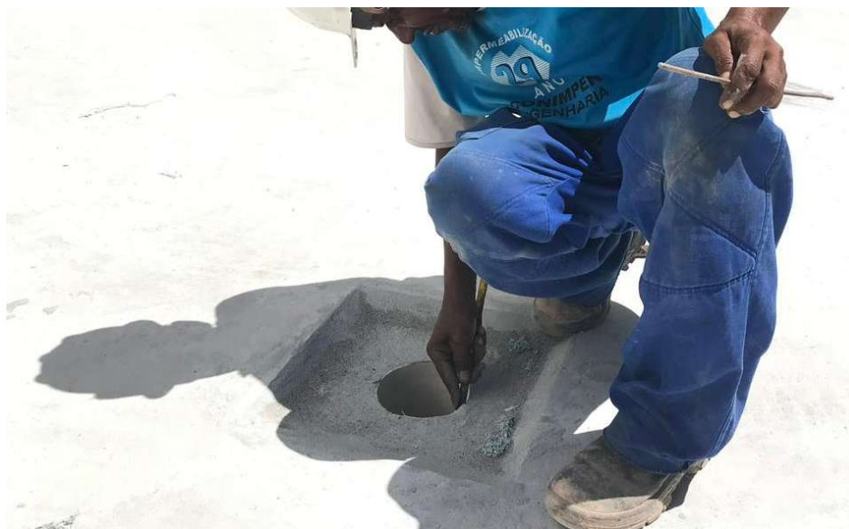
Rebaixo na regularização ao redor dos ralos
