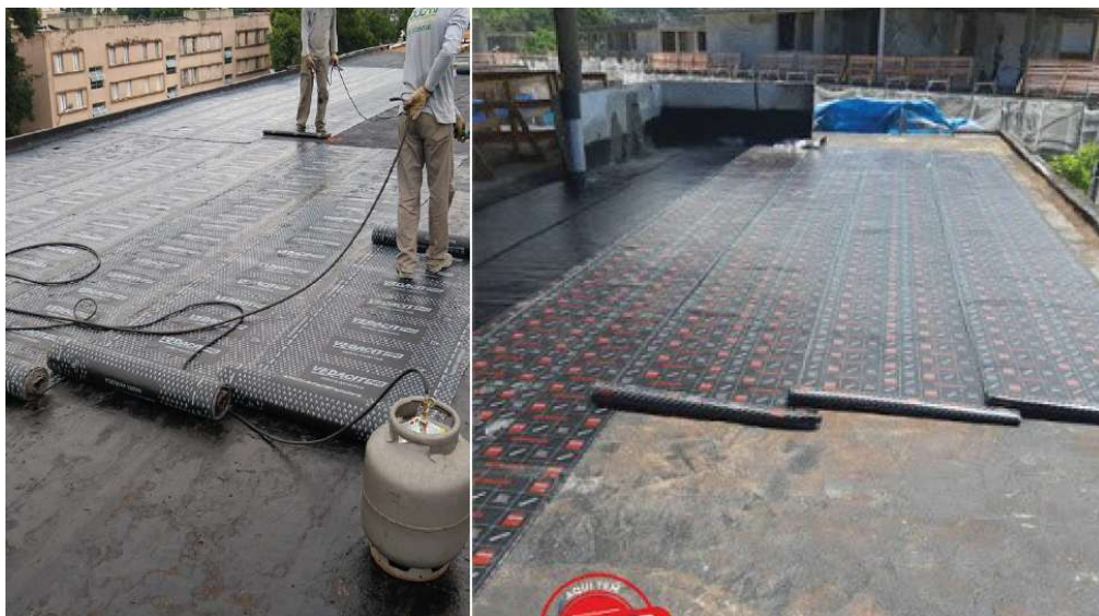
Rolos posicionados antes da aplicação das mantas
