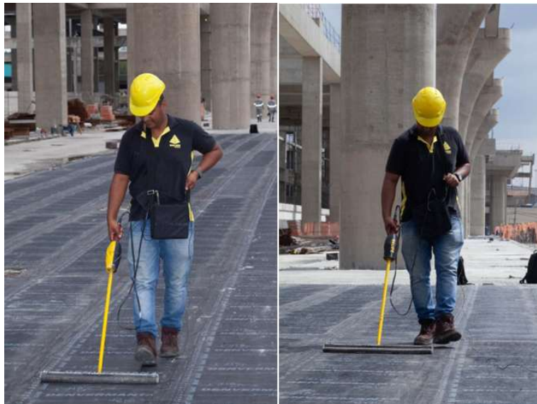
Teste de estanqueidade com equipamento
