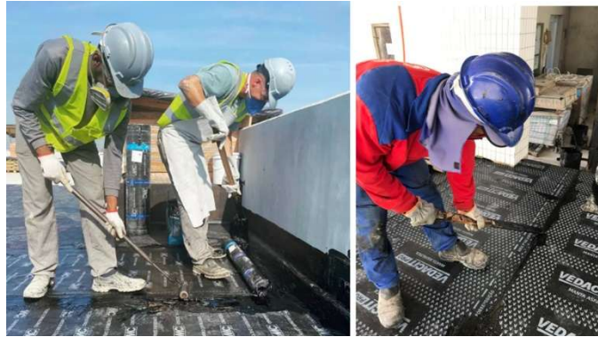
Selamento/biselamento das sobreposições da manta
