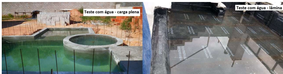
Teste de estanqueidade com água
