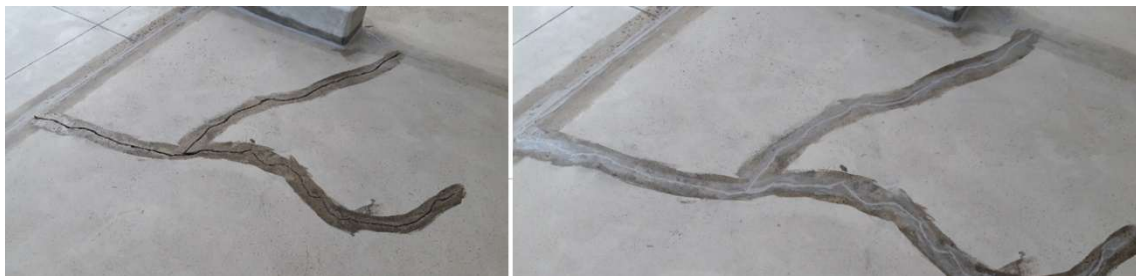
Tratamento das fissuras passivas com selante de poliuretano
