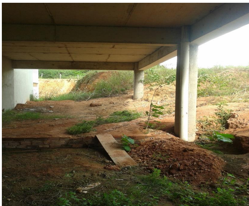
Figura 6- Área 5: fundos do prédio, na lateral direita
