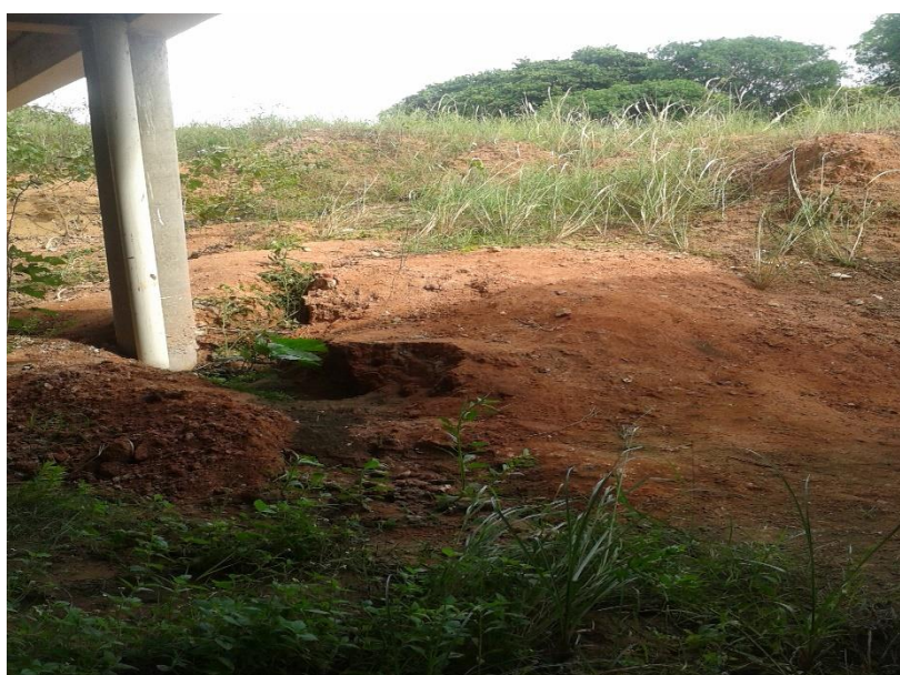
Figura 5- Área 5: fundos do prédio, na lateral direita
