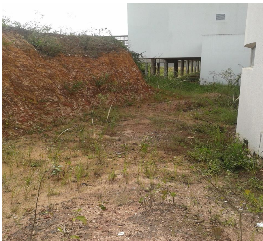
Figura 4- Área 4: fundos do prédio, na lateral direita
