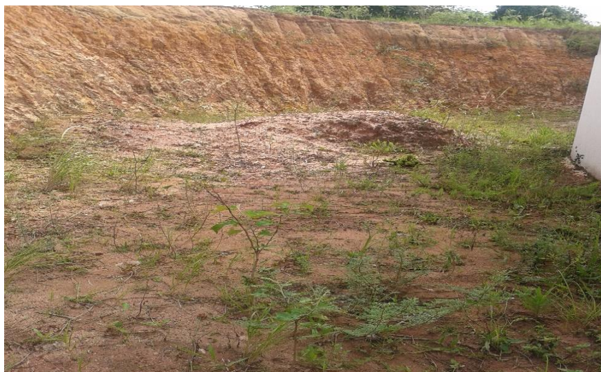
Figura 3- Área 3: Lateral direita do prédio
