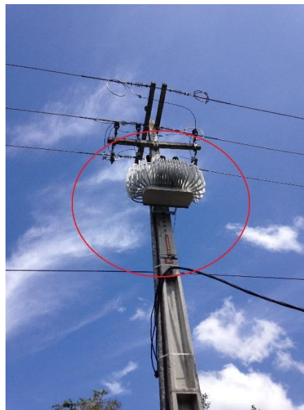
Imagem 3 – Transformador a ser removido no Campus do Cérebro
