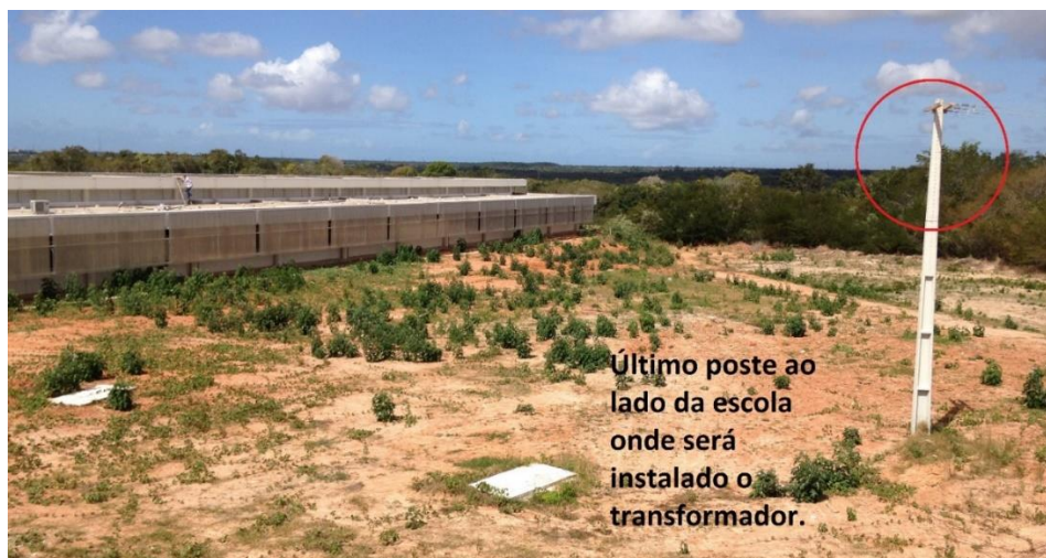
Imagem 5 – Ponto de instalação do segundo transformador de 112,5Kv e caixa de ligação.
